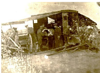
Мастерская развернута. Идет ремонт с левой стороны повозки, в центре – лужение пищевого котла, с правой- ремонт походной полевой кухни.
