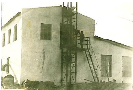
Здание вагранки. На первом плане загрузочное устройство
