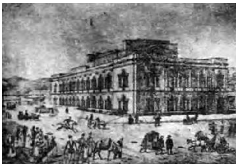
ТИФЛИС. ЗДАНИЕ ТЕАТРА НА ЭРИВАНСКОЙ ПЛОЩАДИ
